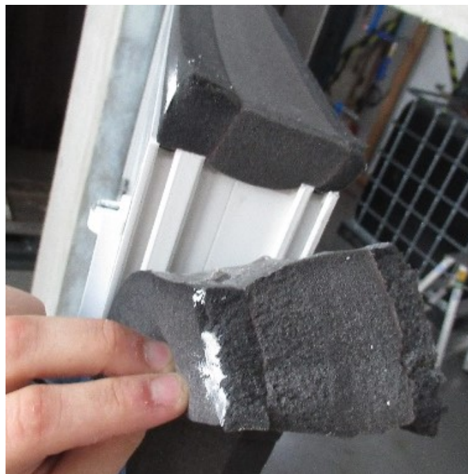
Bild 14 Detailansicht auf den stumpf gestoßen ausgeführten oberen Eckstoß: Das Hannoband®-3E EASY ist in drei Schichten aufgebaut mit dunkel anthrazitfarbigem Außenmaterial und breitem anthrazitfarbigem Mittelteil
