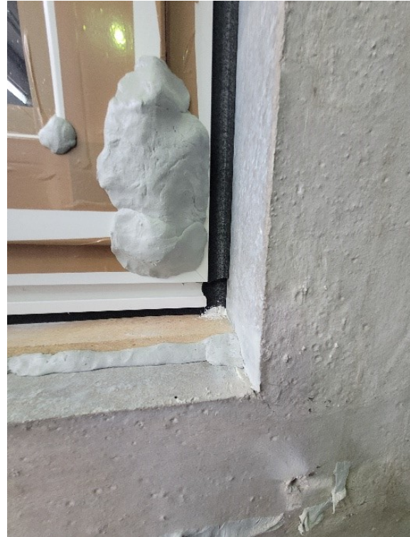
Bild 6 Innenansicht Ecke unten rechts, Hannoband®-3E EASY stumpf gestoßen und mit Hanno®-3E Folienkleber MS nachgedichtet (weiß), Die Leibungsflächen sind vollfächig dünn mit den Folienkleber vorgespachtelt
