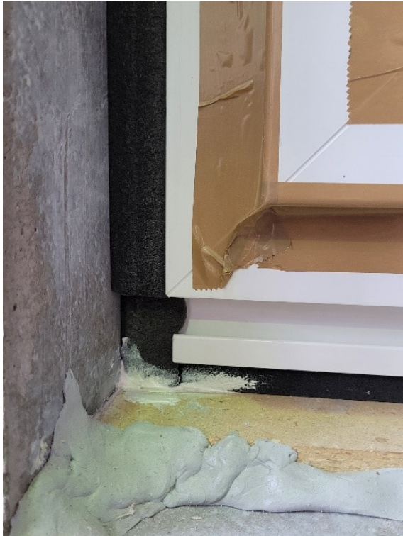
Bild 3 Innenansicht Ecke unten links, Hannoband®-3E EASY stumpf gestoßen und mit Hanno®-3E Folienkleber MS nachgedichtet (weiß), Die Leibungsflächen sind vollfächig dünn mit den Folienkleber vorgespachtelt
