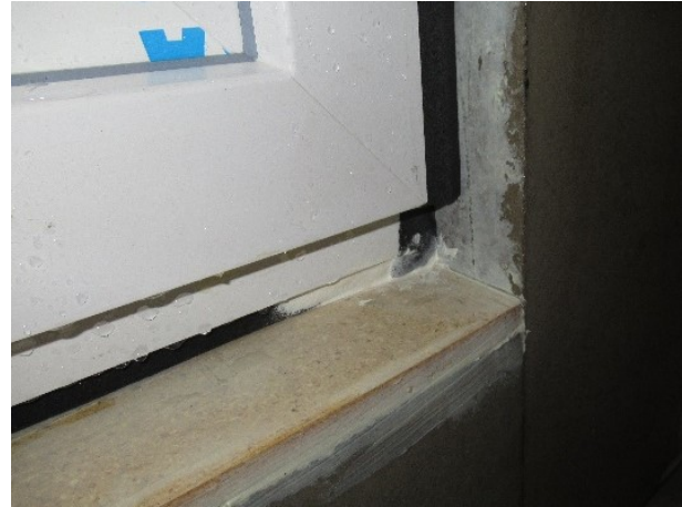
Bild 10 Außenansicht Ecke unten links, Hannoband®-3E EASY stumpf gestoßen und mit Hanno®-3E Folienkleber MS nachgedichtet
