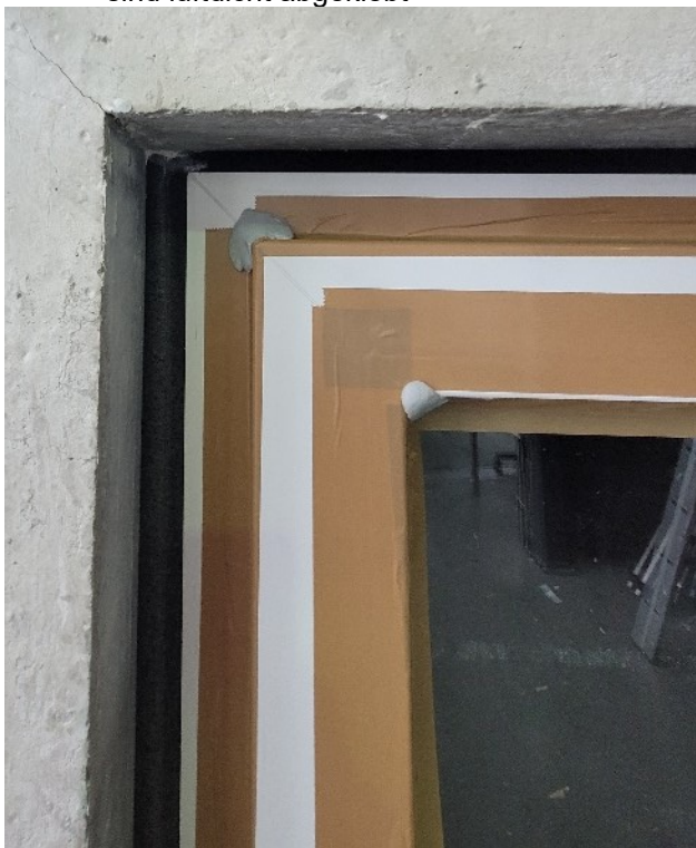
Bild 3 Innenansicht Ecke oben links, Hannoband®-3E EASY stumpf gestoßen und mit Hanno®-3E Folienkleber MS nachgedichtet (weiß)
