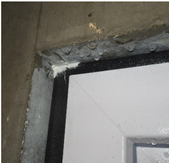
Bild 7 Außenansicht Ecke oben links, Hannoband®-3E EASY stumpf gestoßen und mit Hanno®-3E Folienkleber MS nachgedichtet (weiß) Die Leibungsflächen sind vollfächig dünn mit den Folienkleber vorgespachtelt
