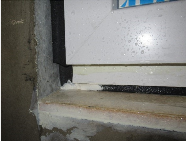
Bild 9 Außenansicht Ecke unten links, Hannoband®-3E EASY stumpf gestoßen und mit Hanno®-3E Folienkleber MS nachgedichtet
