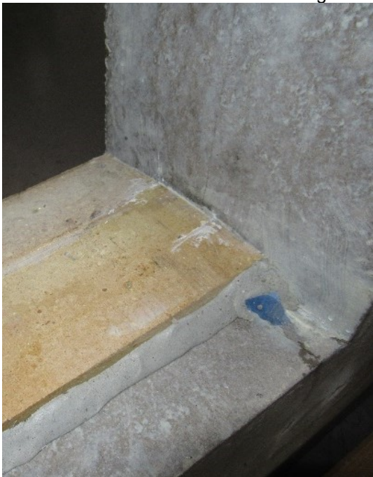
Bild 11 Detailansicht auf die untere rechte Ecke nach Demontage des Fensters, Phonotherm® Dämmkeil mit ablaufschräge nach außen; Leibung vollflächig mit Hanno®-3E Folienkleber MS vorbehandelt; raumseitige Fuge zwischen Dämmkeil und Betonrahmen mit Butyldichtmasse abgedichtet
