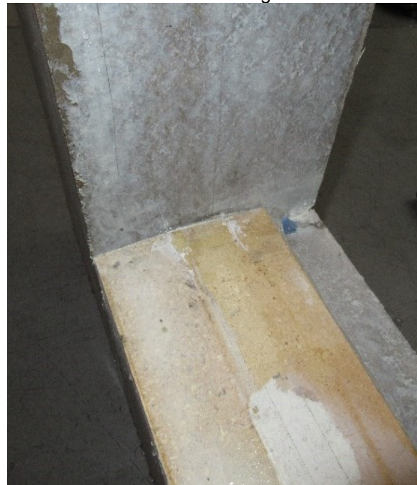
Bild 11 Detailansicht auf die untere linke Ecke nach Demontage des Fensters, Phonotherm® Dämmkeil mit ablaufschräge nach außen; Leibung vollflächig mit Hanno®-3E Folienkleber MS vorbehandelt
