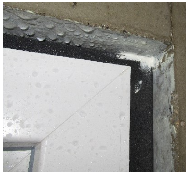
Bild 8 Außenansicht Ecke oben rechts, Hannoband®-3E EASY stumpf gestoßen und mit Hanno®-3E Folienkleber MS nachgedichtet (weiß) Die Leibungsflächen sind vollfächig dünn mit den Folienkleber vorgespachtelt
