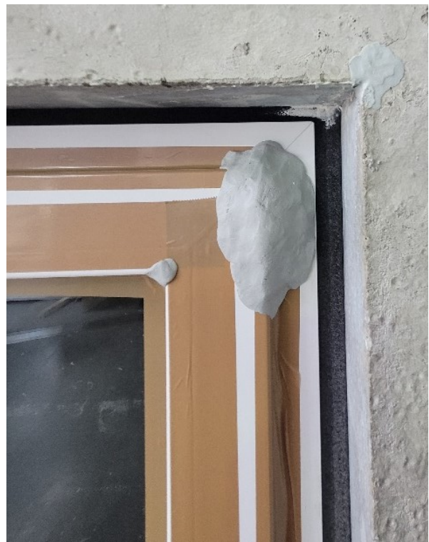
Bild 4 Innenansicht Ecke oben rechts, Hannoband®-3E EASY stumpf gestoßen und mit Hanno®-3E Folienkleber MS nachgedichtet (weiß)
