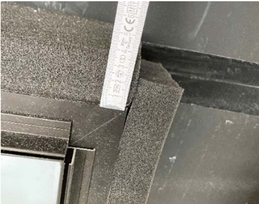
Abbildung 53: Bänder dürfen vor dem Einsetzen der Fenster in das Loch nicht vollständig aufgehen, sondern sollen nach der Positionierung durch Expansion anpressen und abdichten! Stöße sind immer mit ausreichend Materialzugabe auszuführen.
