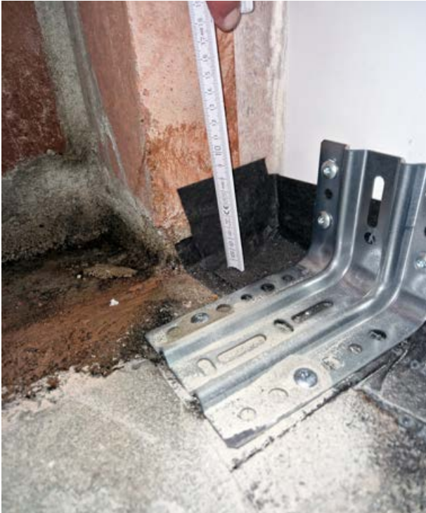
Abbildung 38: Abdichtung der Verbreiterung mit Folienband, anschließend Befestigung mit Montagewinkeln
