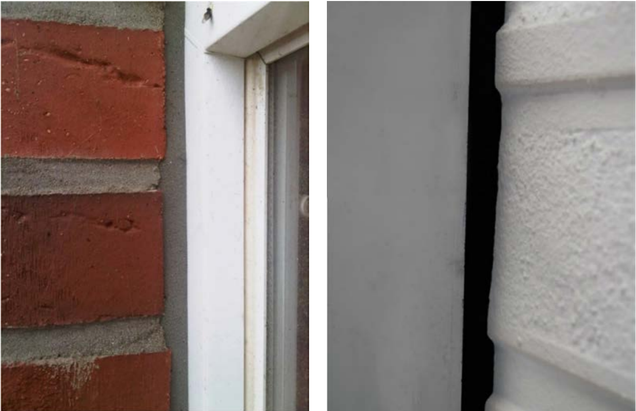
Abbildung 46: Sauber verarbeitetes Fugendichtungsbänder für eine dauerhafte Abdichtung der Anschlussfuge. Der Rücksprung beträgt 1–3 mm, die ausgewählte Banddimension kann sowohl ausreichend Bewegungen aufnehmen als auch vorliegende Unebenheiten ausgleichen.
