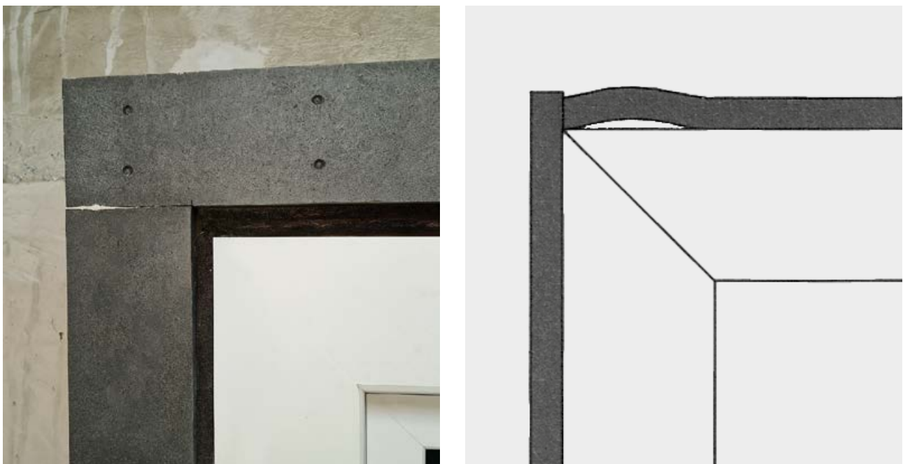
Abbildung 48: Sauber und fachgerecht ausgeführte Ecke innerhalb eines Vorwandmontagesystems
