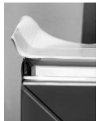
Abbildung 37: Beispielhafte Darstellung zur Abklebung von Laschen und Befestigungsmitteln
