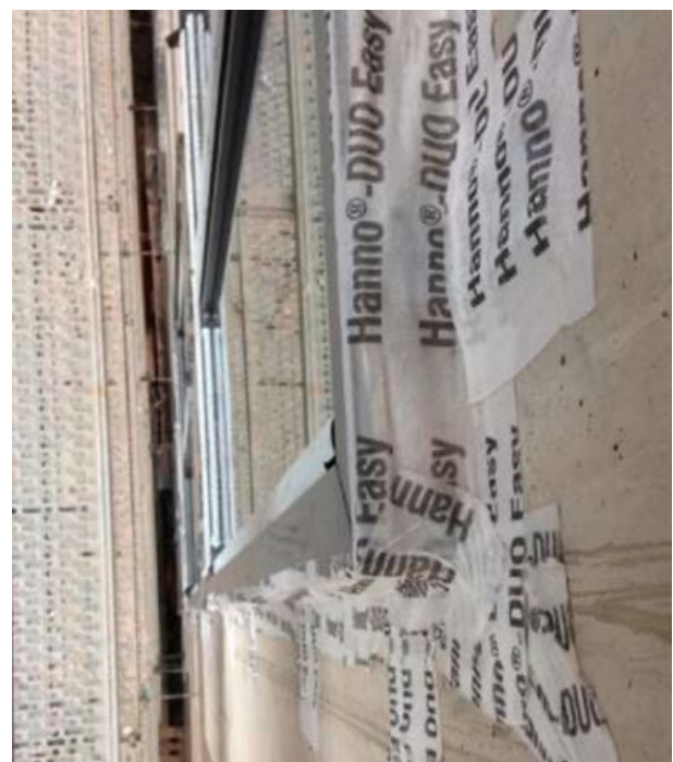
Abbildung 17: Einfohlenlösung in der Praxis (Quelle: HANNO)
