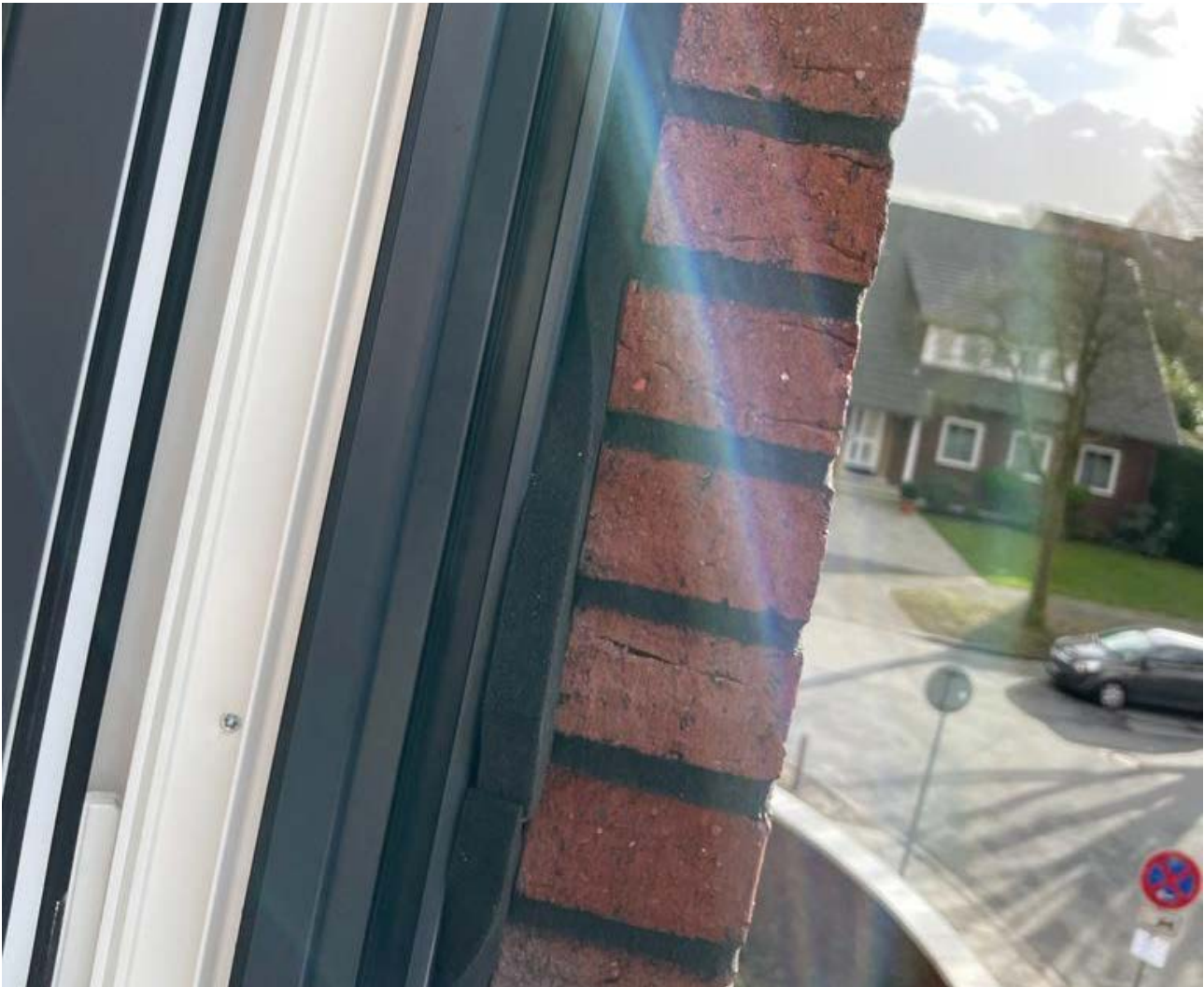
Abbildung 19: Ein Band darf gem. LzM oder RAL GZ711 nicht weiter aufgehen, als das Maß seiner Schnittbreite. Ein Verhältnis > 1:1 begünstigt ein Herausarbeiten durch Bauteilbewegungen und Längenausdehnungen. Die spitzen Anfänge und Enden einer Rolle sind nicht dafür da, um das Band versatzfrei zu fügen; sie sind herstellungsbedingt. Die Zellstruktur der „Spitze“ wird sich nicht so zurückstellen wie der Rest vom Produkt und ist in jedem Fall abzuschneiden.
