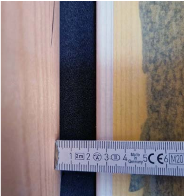
Abbildung 49: Multifunktionsbänder benötigen, genau wie vorkomprimierte Dichtbänder aus Schaumkunststoff, parallele Fugenflanken (Bild links) für eine dauerhafte Funktion und Abdichtung. Der maximale Fugeneinsatzbereich ist einzuhalten und nicht zu überschreiten.
