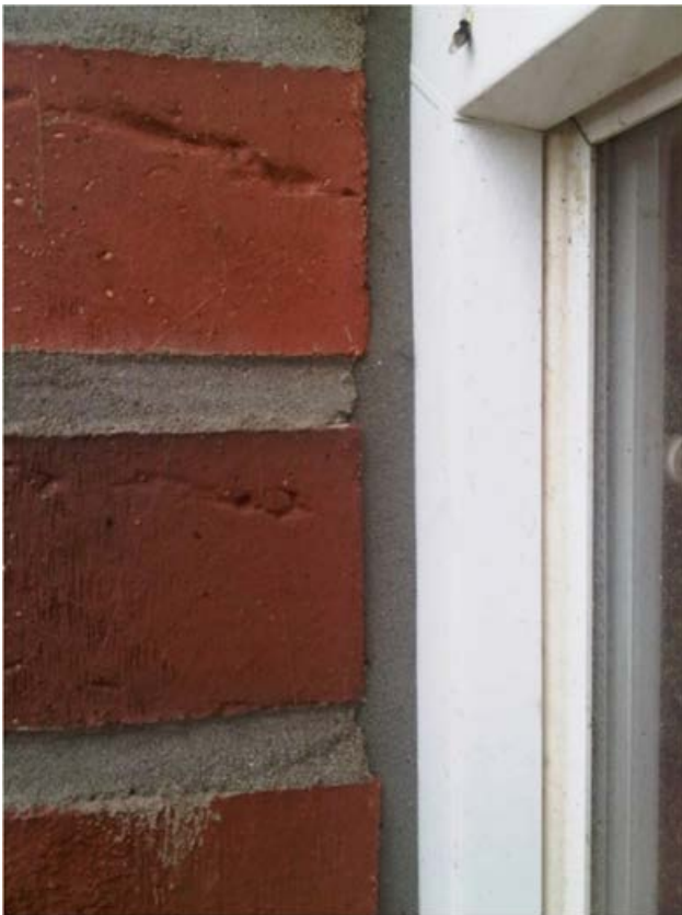
Abbildung 46: Sauber verarbeitetes Fugendichtungsbänder für eine dauerhafte Abdichtung der Anschlussfuge. Der Rücksprung beträgt 1–3 mm, die ausgewählte Banddimension kann sowohl ausreichend Bewegungen aufnehmen als auch vorliegende Unebenheiten ausgleichen.
