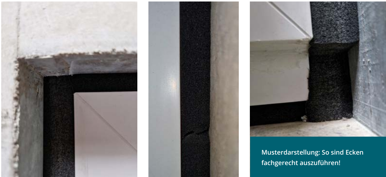
Abbildung 47: Stöße (Bild Mitte) und Eckausbildungen (Bilder links und rechts), hier dargestellt an einem Prüfkörper für die MO/01-Prüfung vom ift Rosenheim, sind sauber auszuführen! Das Band muss um die ermittelte Fugenbreite überstehen, um in den Ecken dicht abzuschließen. Bild Mitte: Nur ein sauber und gerade geschnittenes Band kann einen Stoß abdichten!
