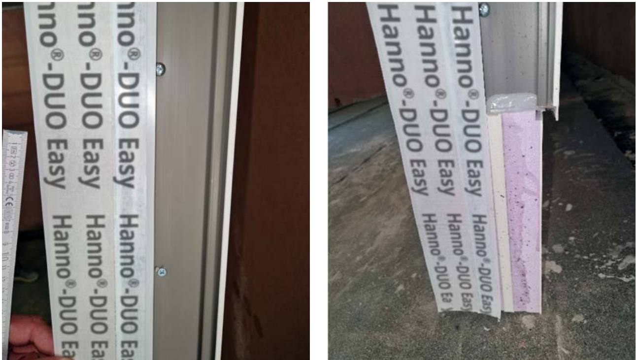
Abbildung 30: Saubere Verklebung auf den Stegen des Profils. Bitte beachten: Nicht auf jedem Dichtstoff lässt sich eine gleichwertige Haftung erzielen! Polymer = i. d. R. gute Haftung; Silikon in den meisten Fällen schlechte bis keine Haftung.
