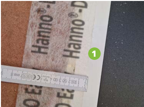
Abbildung 6: Klebebreite knapp unter 15 mm, jedoch sauber verarbeitet → Ausführung kann dauerhaft funktionieren!
