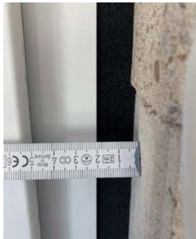
Abbildung 54 (Erklärung von links nach rechts): Der Stoß ist mit zu geringer Materialzugabe ausgeführt (offene Fuge) und der Fugeneinsatzbereich vom Produkt ist zu gering für Fuge am Bau (an der offenen Struktur vom Band zu erkennen). Im mittleren Bild wurde das Band in geeigneter Dimension gewählt, weshalb die Fuge verschlossen ist. Auf der rechten Seite ist die Nachbesserung von Fehlstellen mit einem geeignetem MS-Polymer in der Praxis zu sehen.
