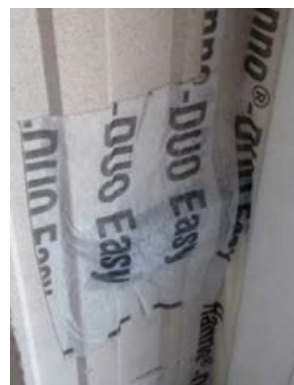
Abbildung 37: Beispielhafte Darstellung zur Abklebung von Laschen und Befestigungsmitteln
