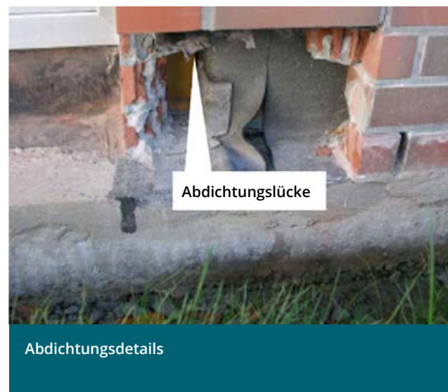
Abbildung 59: Sanierungssituation ist Fenstertausch mit Anschluss an vorhandene Bauwerksabdichtung (Quelle: Der vergessene Anschluss, Dipl.-Ing. Henrik-Horst Wetzell)
