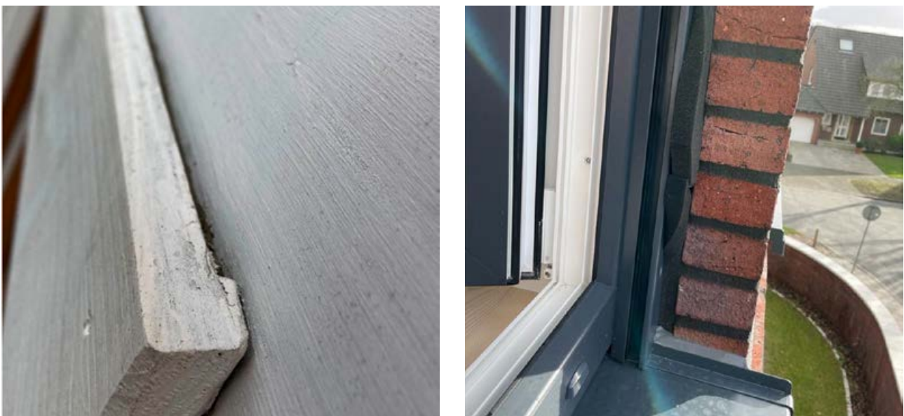
Abbildung 45: Fugendichtungsbänder (links) sind nicht für Situationen mit stehendem Wasser geeignet! Wasser muss IMMER konstruktiv abgeführt werden, da das Produkt sich vollsaugt und mit der Zeit Wasser durchlässt! Rechts: Maximalfuge des Bandes, zu finden auf der Banderole, und Verhältnis 1:1 von Schnittbreite (z. B. 15 mm) zu Fugenbreite (z. B. 10 mm) darf nicht überschritten werden → Band arbeitet sich heraus und ist nicht mehr UV-stabil! Die spitzen Enden der Bänder entstehen durch einen Gehrungsschnitt bei der Endlos-Fertigung der Rohschäume. Diese werden nicht vollständig expandieren und sind nicht dafür gedacht, nahtlos anzusetzen. Die spitzen Enden sind abzuschneiden und zu entsorgen!
