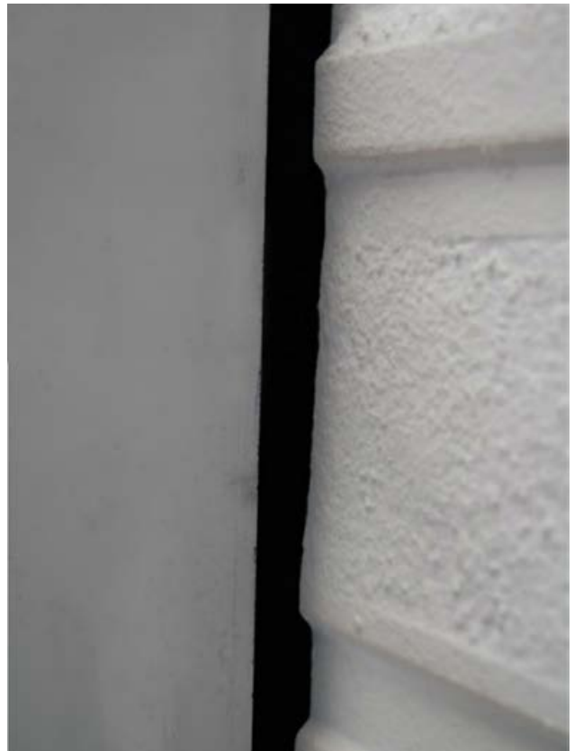
Abbildung 46: Sauber verarbeitetes Fugendichtungsbänder für eine dauerhafte Abdichtung der Anschlussfuge. Der Rücksprung beträgt 1–3 mm, die ausgewählte Banddimension kann sowohl ausreichend Bewegungen aufnehmen als auch vorliegende Unebenheiten ausgleichen.
