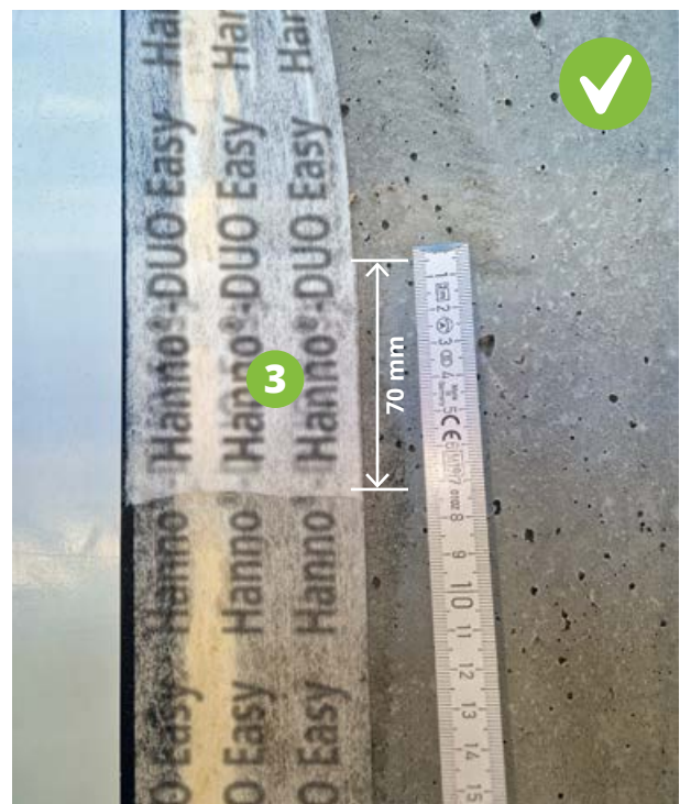
Abbildung 13: Großzügige, gut verarbeitete Überlappung
