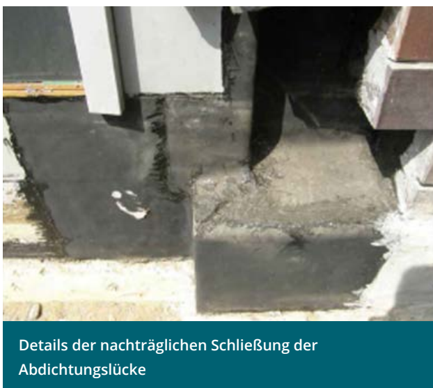
Abbildung 59: Sanierungssituation ist Fenstertausch mit Anschluss an vorhandene Bauwerksabdichtung (Quelle: Der vergessene Anschluss, Dipl.-Ing. Henrik-Horst Wetzell)
