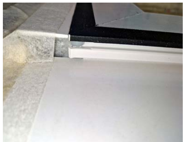
Abbildung 27: Anspruchsvolle Geometrien lassen sich vor der Montage verfüllen, nachträglich jedoch nur schwer ausbessern. Wichtig: Ist ein Dichtstoff nicht überstreichbar (z. B. Silikon) so kann dies im Anschluss einen Trennfilm bilden.
